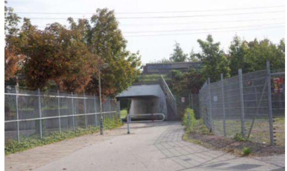
Cykelväg Norbergsgångens tunnel under kontinentalbanan
